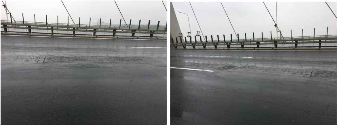
图 5-2 主桥钢桥面铺装连片坑槽、网裂
