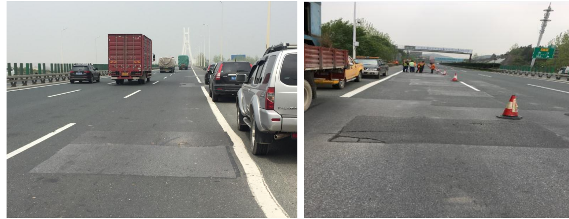
图 6-3 引桥桥面铺装严重连片坑槽、网裂、推移
